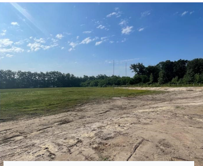
Travaux de drainage au stade André Rivière
