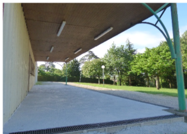
Des aménagements extérieurs Salle Polyvalente Louis Barranger
