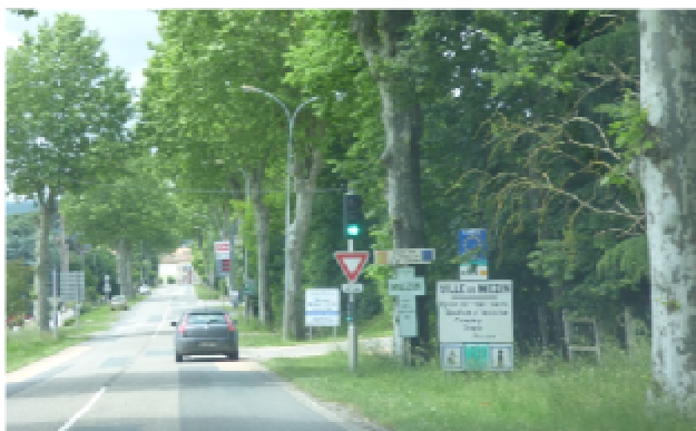
Aménagement et installation de feux tricolores avenue Cassagnabère : les sapeurs pompiers pourront emprunter la D656 en toute sécurité.
