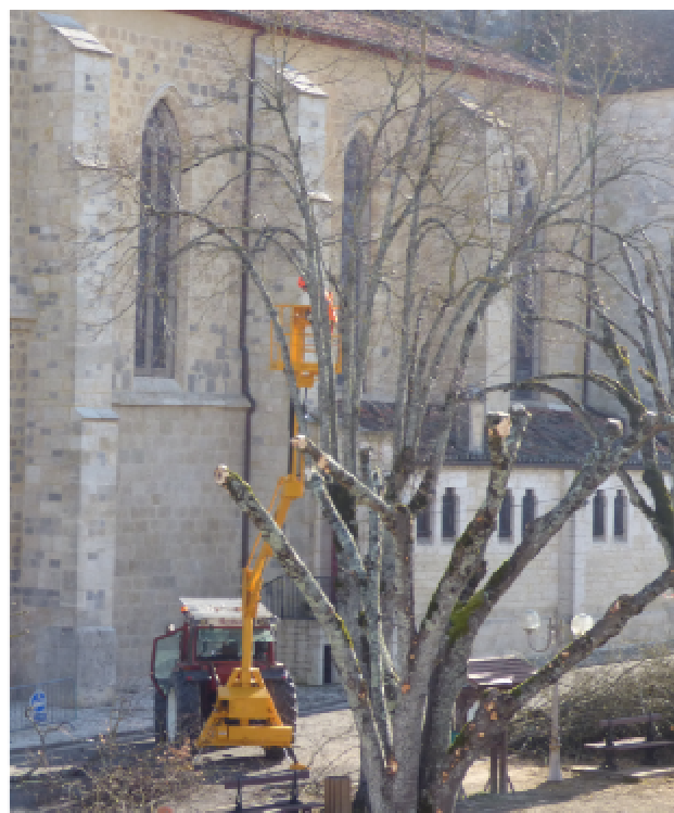
Travaux d'élagage place du club
