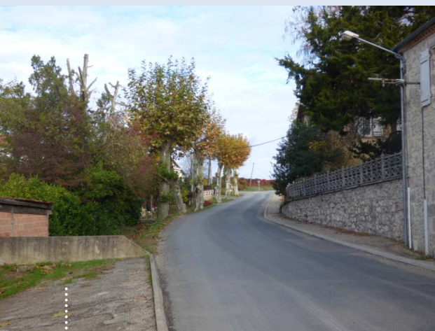
Travaux de voirie - route de Courbian
