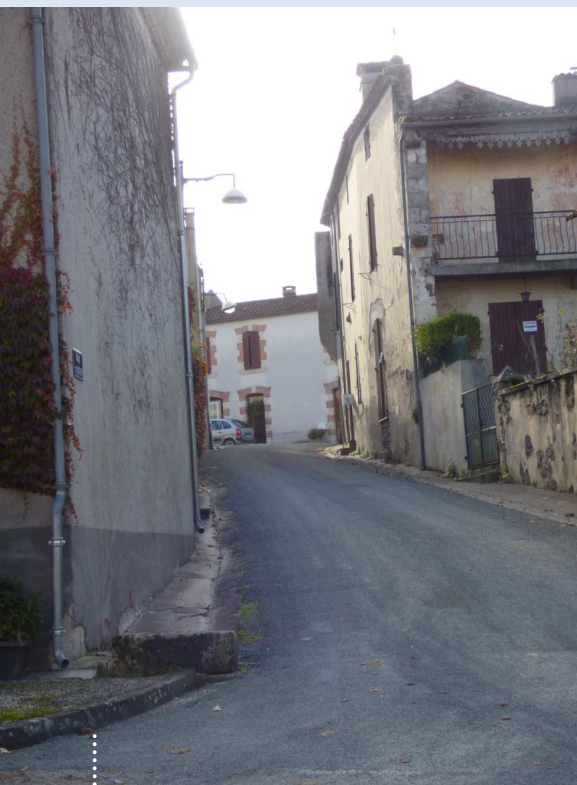
Travaux de voirie - rue Enghien
