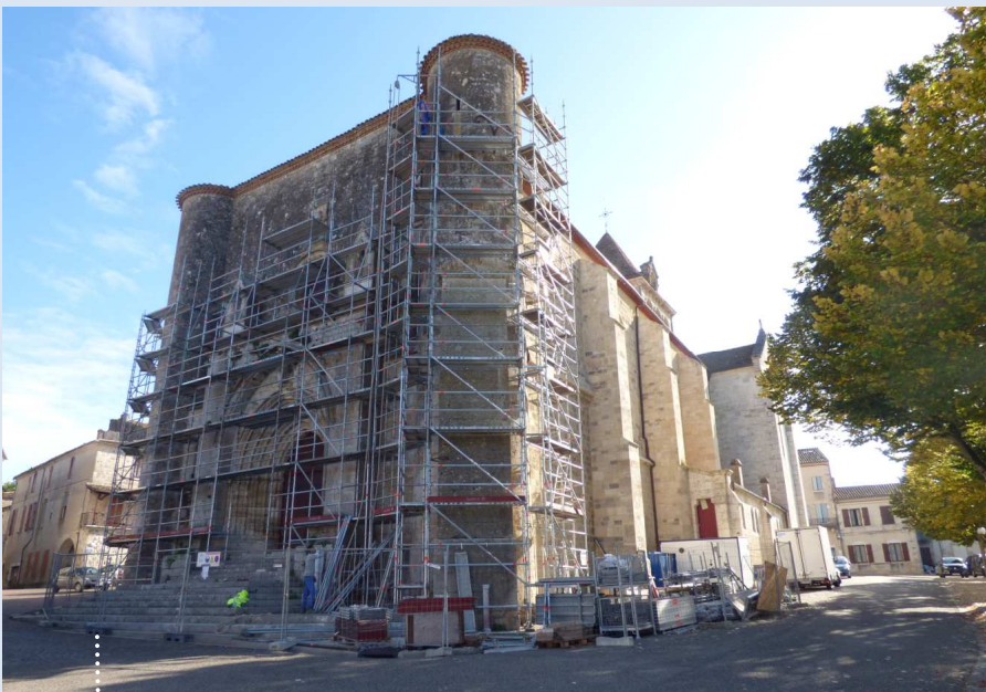
Une nouvelle tranche de travaux programmée - Eglise St Jean Baptiste
