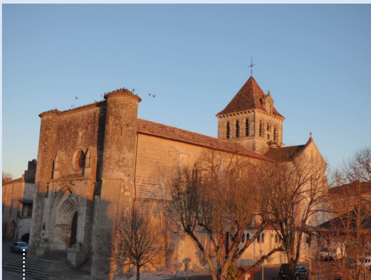
Une nouvelle tranche de travaux programmée - Eglise St Jean Baptiste
