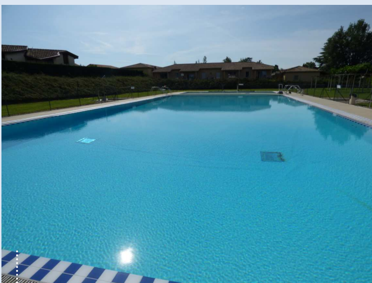
Reprise des malfaçons à la piscine municipale
