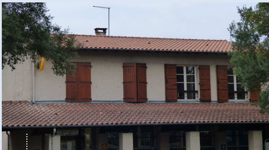
Nouvelle toiture pour le bâtiment de La Poste
