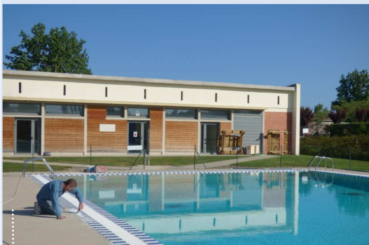
Reprise des malfaçons à la piscine municipale
