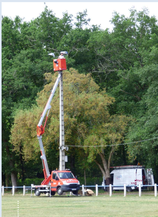
Installation d'un nouvel éclairage - Stade A. Rivière
