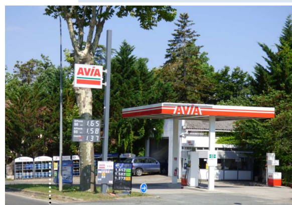
La nouvelle station service
