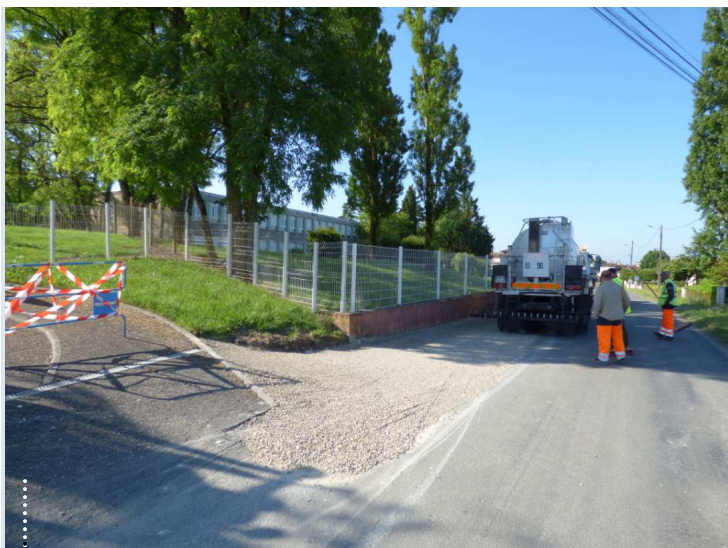
Travaux de voirie - route de l'ange
