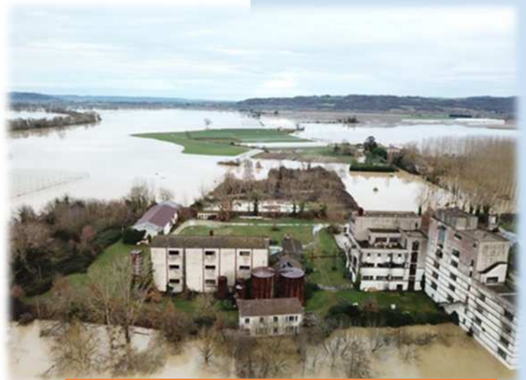
Plaine inondée, crue de février 2021-Photo : I.Caire
